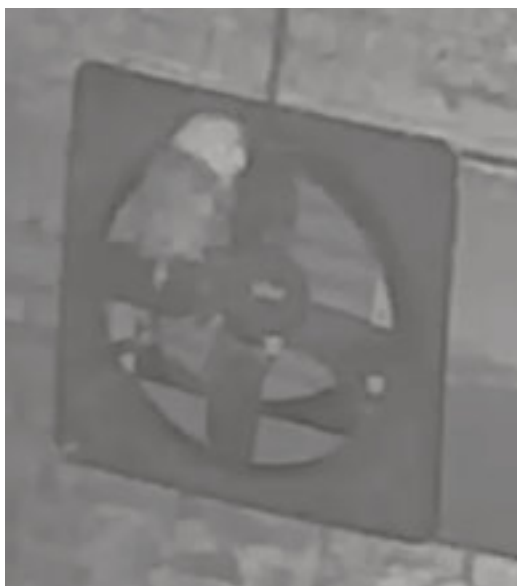
Foto links: overzicht plaats ventilator in schuur. U ziet de uil al zitten.
